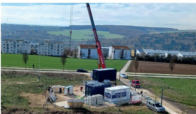
Abbildung 26 | Aufbau Gasturbine im Energiepark am Standort AEA
