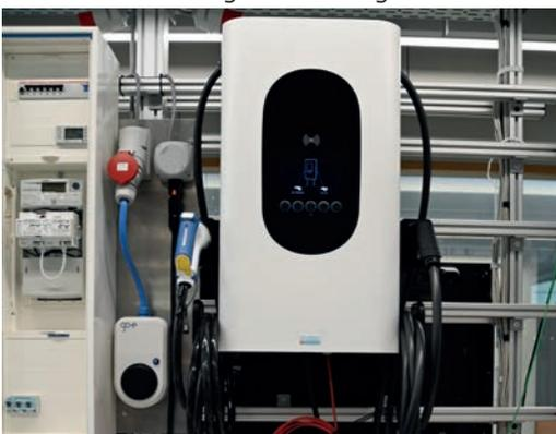
Abbildung 28 | Inbetriebnahme einer bidirektionalen E-Ladesäule.
