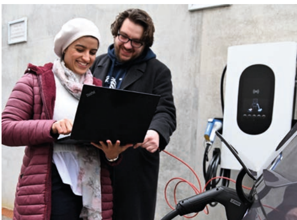
Abbildung 26 | Erweiterung des Smart Grid Labors um Ladeinfrastruktur zur Untersuchung von bidirektionalen Ladevorgängen bei Elektro-Fahrzeugen
